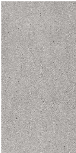
Concreto Aparente En Escaleras
